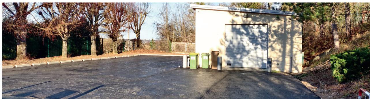
A la demande de la mairie, des travaux d'élargissement du trottoir ont été réalisés dans la rue des Plantes aux Moines afin de permettre un cheminement plus sûr des piétons tout en ralentissant la vitesse des véhicules par le rétrécissement de la voie de circulation (8205 € HT).
